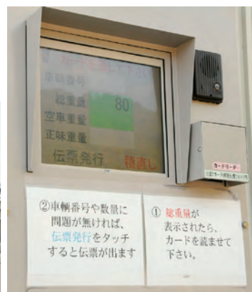
製品の積み込みを終えた車両は退場する際、計量時にカードを読み込ませ、出荷計量伝票が自動で発行される
