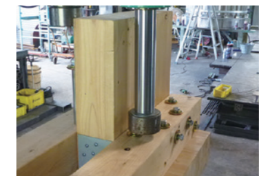
油圧挿入機の導入で、エアータ具を使用した
